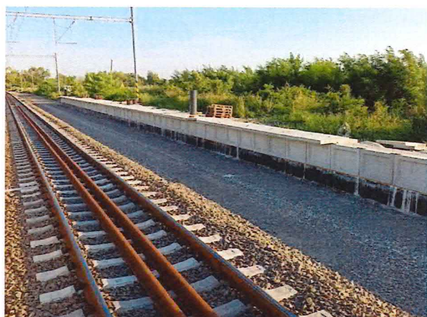
UČS 11, Montáž konzol. dosiek - nástupisko
