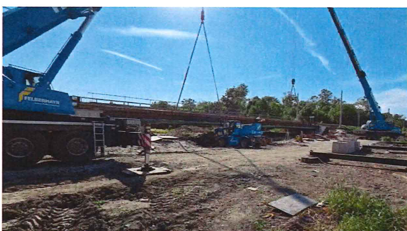
UČS 12, Osádzanie ložísk a ocelejovej mostovky
