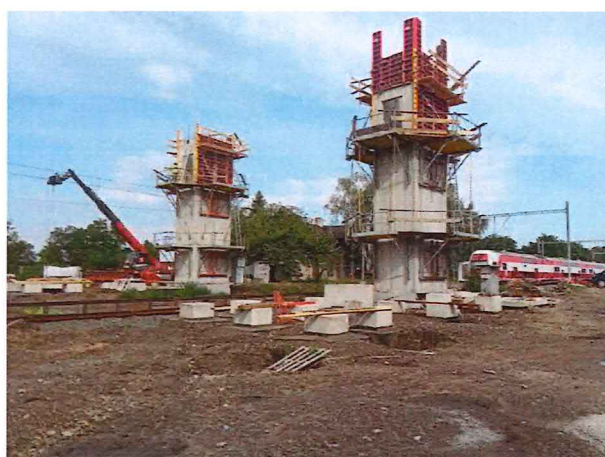
UČS 01, Armovanie, debnenie a betonáž výtáhových šácht, lávka pre cestujúcich
