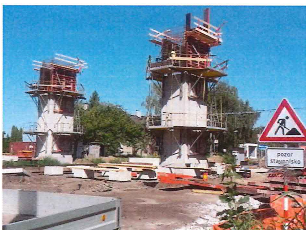
UČS 01, Armovanie, debnenie a betonáž výtáhových šácht, lávka pre cestujúcich
