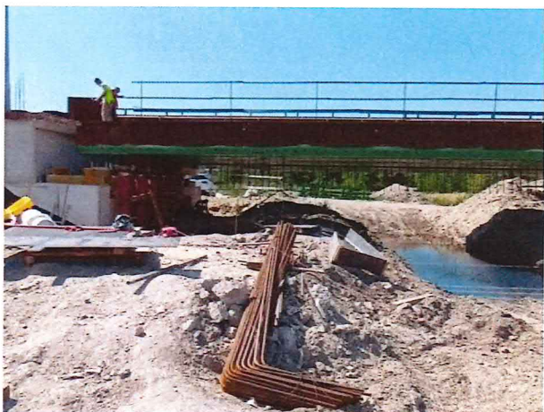
UČS 12 Montáž strateného debnenia a kontrolné meranie, mosty
