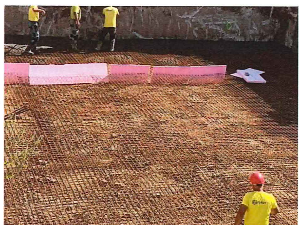
UČS 11, Betonáž podkladovej dosky, podjazd
