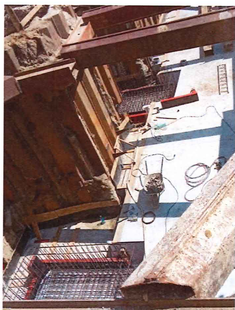
UČS 02, Armovanie základov výťahových šachtiet, podchod
