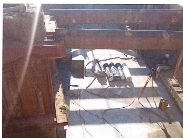
UČS 02, Odstránenie spodného rozperného rámu, a spodná izolácia podchodu
