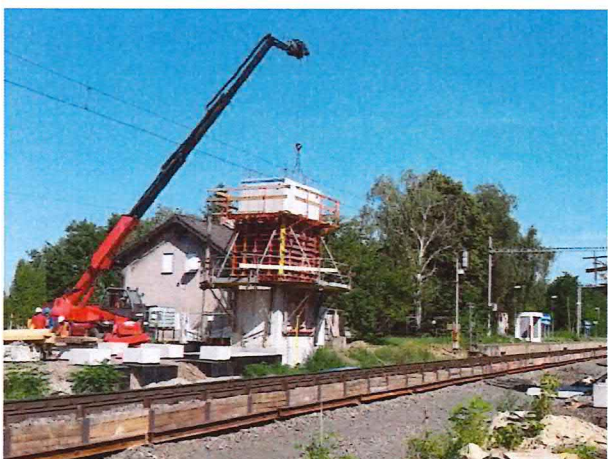
UČS 01, Armovanie, debnenie a betonáž výťahových šacht, lávka pre cestujúcich
