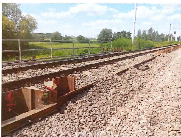
UČS 01, Realizácia záporového paženia, priepusty
