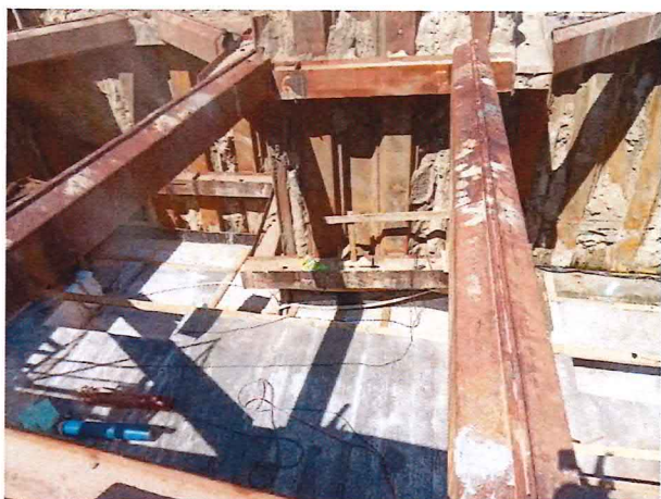
UČS 02, Odstránenie spodného rozperného rámu, a spodná izolácia podchodu
