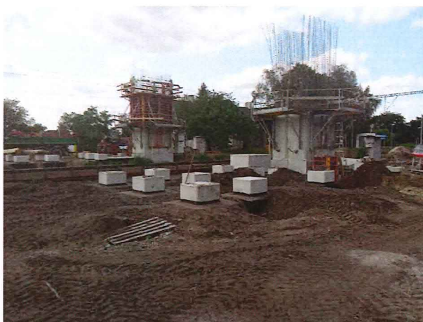
UČS 01, Armovanie, debnenie a betonáž výťahových šacht, lávka pre cestujúcich
