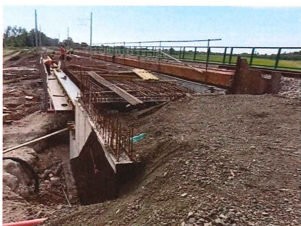
UČS 12, Debnenie a armovanie mostovky
